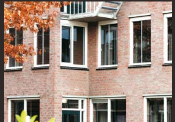
AJ-kozijn in het gevelbeeld
